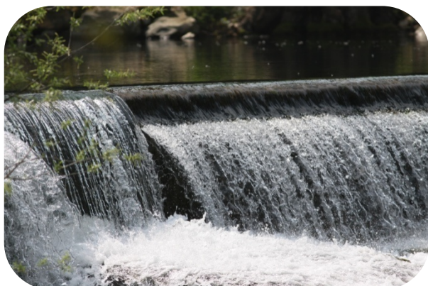
Photographie 20 : seuil difficile à franchir par les poissons
