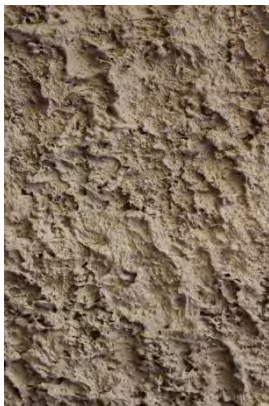
Enduit inadapté (matériau et texture)
