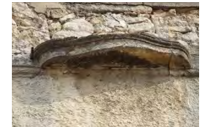
Console de balcon filant du 1er étage.
