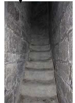
Tour d'Argent (ou Tour Boutin) : le fait qu'elle ait subi des remaniements avec percement de baies au rez-de-chaussée montre ses dimensions colossales ( Murs d'épaisseur 2m30, hauteur 17m, salle d'honneur carrée de 7m20 de côté (*6)). Les vestiges de baies (a) qui restent sont de modestes prises de jour, l'accès se faisait par une porte au 1er étage qui desservait le 2ème étage par l'escalier (b) réalisé dans l'épaisseur du mur.
