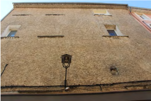
Enduit inadapté (matériau et texture)
