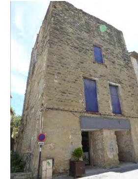
Tour d'Argent (ou Tour Boutin) : le fait qu'elle ait subi des remaniements avec percement de baies au rez-de-chaussée montre ses dimensions colossales ( Murs d'épaisseur 2m30, hauteur 17m, salle d'honneur carrée de 7m20 de côté (*6)). Les vestiges de baies (a) qui restent sont de modestes prises de jour, l'accès se faisait par une porte au 1er étage qui desservait le 2ème étage par l'escalier (b) réalisé dans l'épaisseur du mur.
