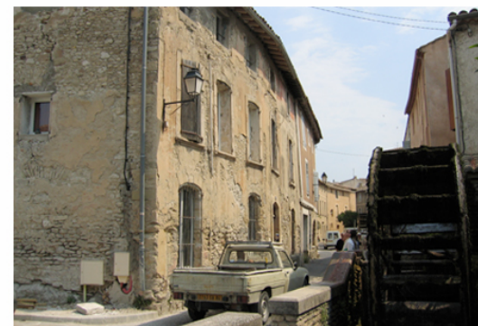
Façade de fabrique
