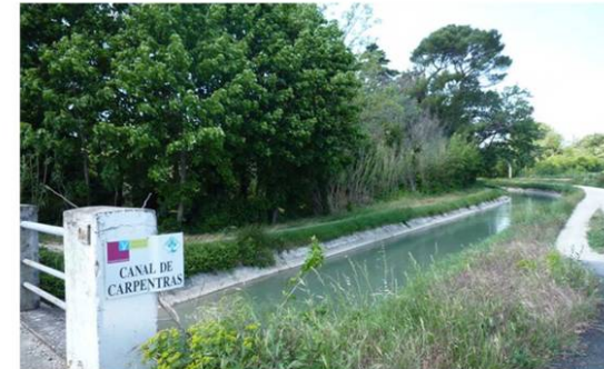
Le canal de Carpentras à la cote NGF 100 mètres
