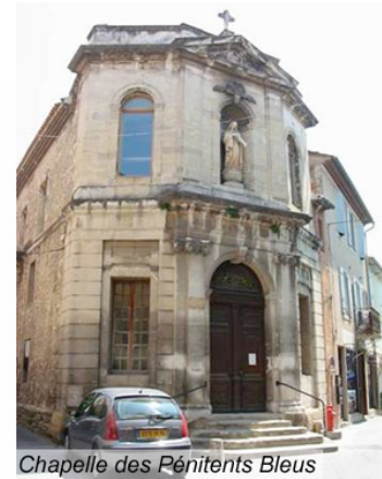
Chapelle des Pénitents Bleus Edifices religieux
