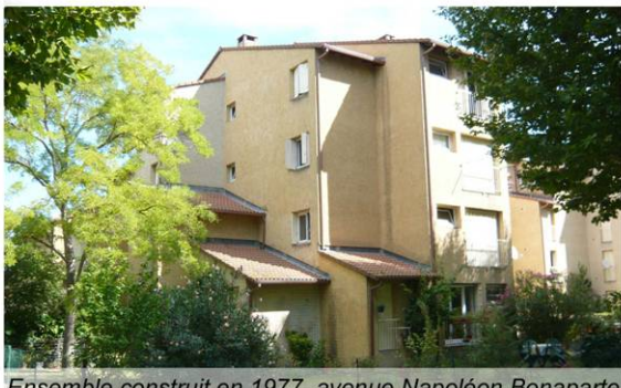
Ensemble construit en 1977, avenue Napoléon Bonaparte
