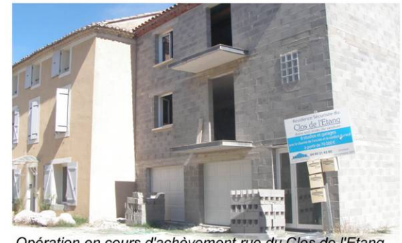
Opération en cours d'achèvement rue du Clos de l'Etang
