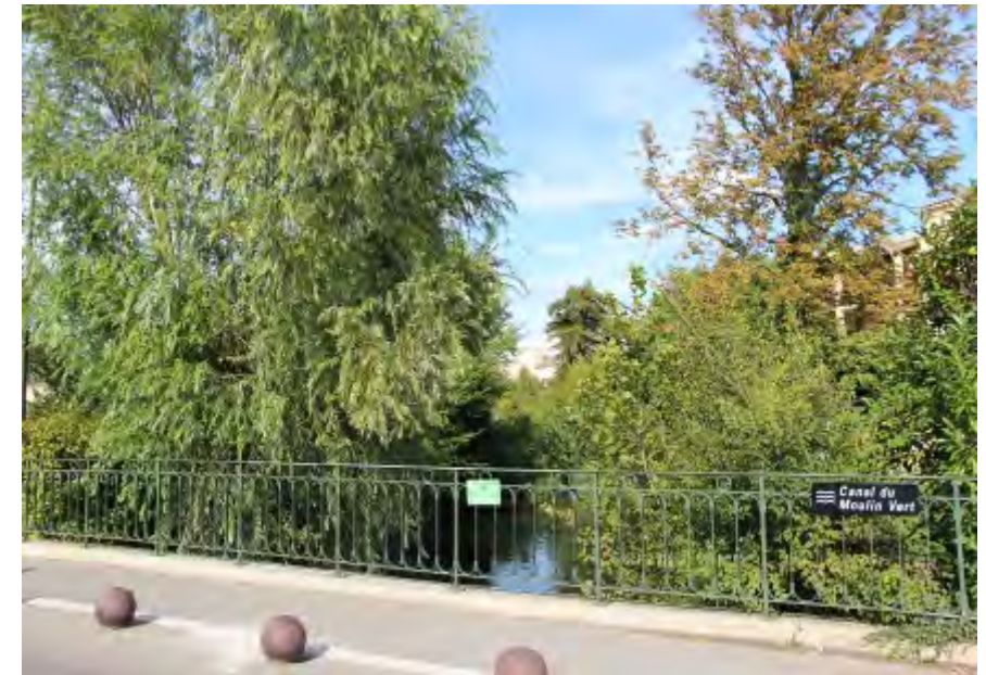
Franchissement du Canal du Moulin Vert
