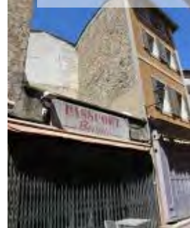
3. Mur aveugle qui reste
