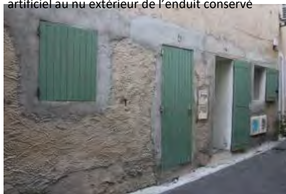
Ouverture de baie avec rebouchement au ciment artificiel au nu extérieur de l'enduit conservé
