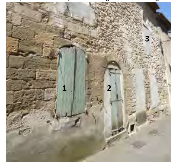
Façade rue Molière, ancien mur gouttereau de l'église
