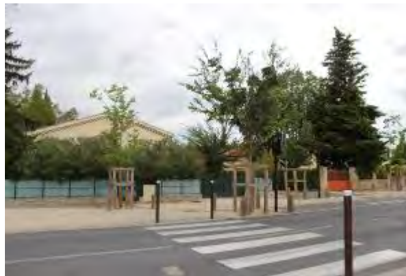
Hétérogénéité de traitement des clôtures...
