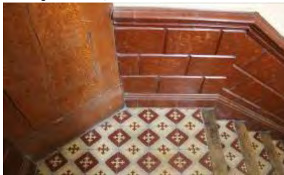
Décor de cimaise en stuc-marbre supposé XIX ème et carrelage en ciment, fin XIX ème
