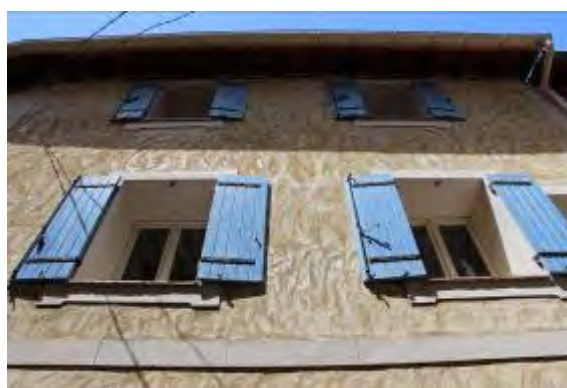
Ouverture de baie avec rebouchement au ciment artificiel au nu extérieur de l'enduit conservé
