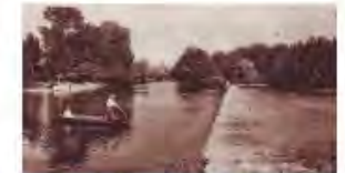
Bassin des Espeluques ou Partage des Eaux
