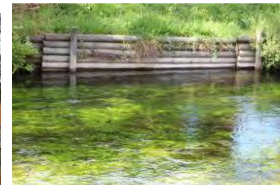
Confortement des berges par piquetage
