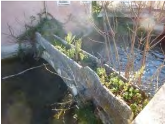
Franchissement d'un bras de sorgue au Pont des Cinq Eaux
