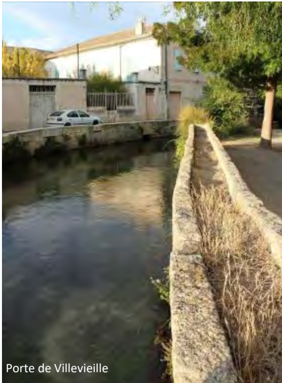
Aqueduc utilisé en réemploi pour former un garde corps ou en place suivant leur dispositif d'origine
