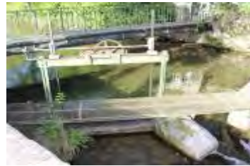
Martelière & Vanne de l'ancien Moulin Vert détails d'ouvrage hydraulique
