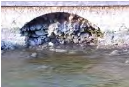
Soutènement des berges Sorgue des jardins
