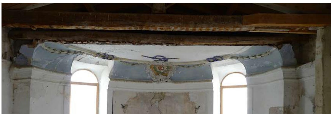
Panoramique du plafond subsistant dans sa partie Ouest(ancienne tribune) -Photo Direction du Patrimoine 2013 (détail)
