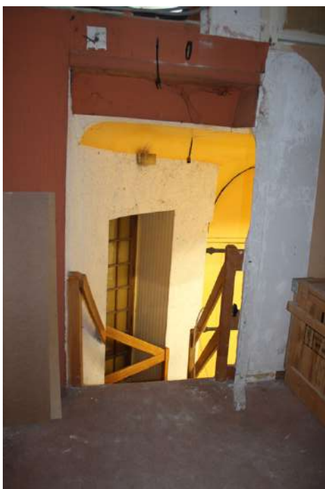
départ escalier bois moderne qui désert le plancher intermédiaire (1975)
