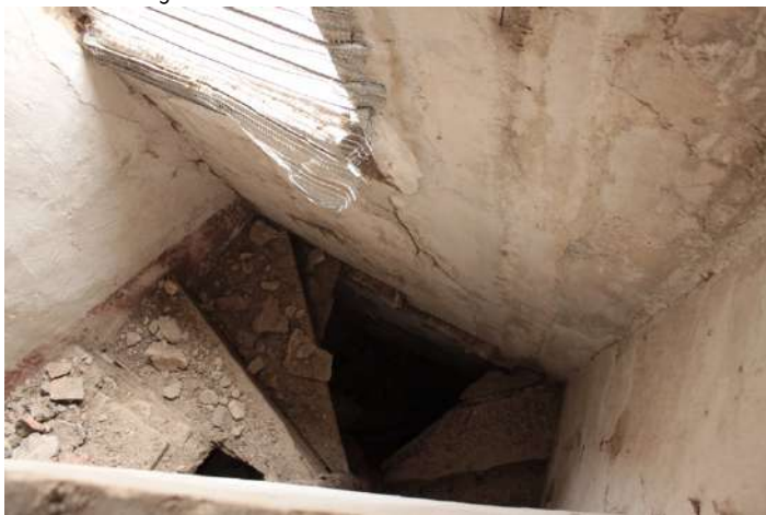
vue plongeante du petit escalier d'accès à la tribune
